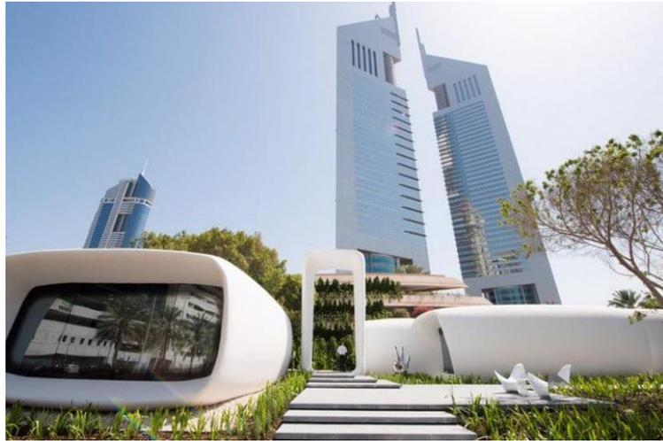
**ILUSTRACIÓN 16: PRIMER EDIFICIO CONSTRUIDO CON IMPRESIÓN 3D. DUBAI. WINSUM GLOBAL. FUENTE:**
